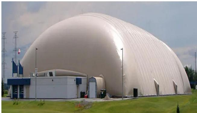
Рисунок 2- Общий вид пневматического сооружения надувного типа
