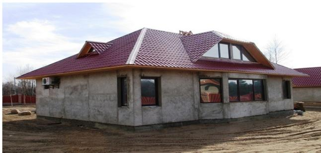
Рис. 1. Возведение малоэтажного здания из монолитного железобетона
