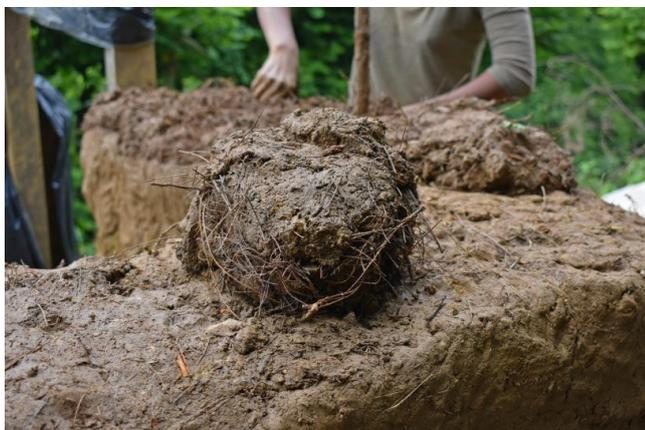
Рис. 4. Типичная техника строительства саманных стен для сельских зданий Ганы [38]
