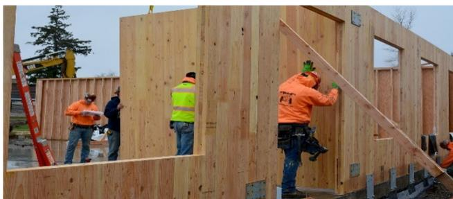
Рис. 5. Строительство модульных классов.
