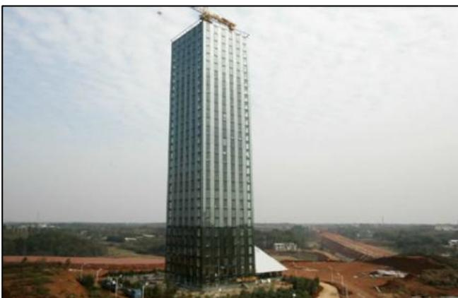
Рис. 3 Отель в провинции Китая, построенный по модульной технологии
