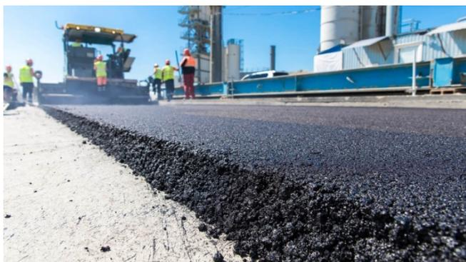
Рис. 1. Классический мелкозернистый асфальтобетон
